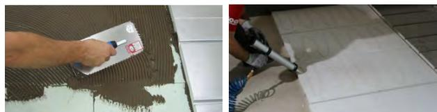
Werden weitere Dämmschichten unterhalb der Systemelemente verlegt, so sind diese ebenfalls zu verkleben. Zusätzlich müssen die Dämmschichten grundsätzlich versetzt verlegt werden, damit nicht Kanten der einzelnen Dämmlagen direkt übereinander liegen (zusätzliche Stabilität). Beachten Sie unbedingt bei der Verlegung der unteren Dämmlagen, die Lage der JOCO KlimaBoden TOP 2000® Elemente gemäß Verlegeplan.
