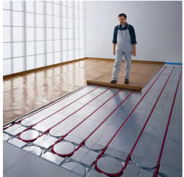
Die beschichtete Seite der JOCO Trenn- und Gleitlage wird nach oben verlegt. Schrift lesbar!
