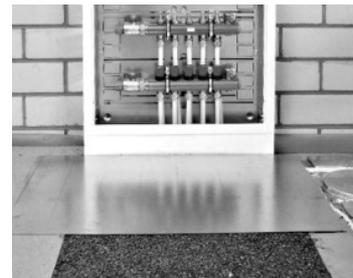
JOCO Trenn- und Gleitlage mit beschichteter Seite nach oben, Ränder 10 cm überlappend verlegen.
