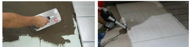
Werden weitere Dämmschichten unterhalb der Systemelemente verlegt, so sind diese ebenfalls zu verkleben. Zusätzlich müssen die Dämmschichten grundsätzlich versetzt verlegt werden, damit nicht Kanten der einzelnen Dämmlagen direkt übereinander liegen (zusätzliche Stabilität). Beachten Sie unbedingt bei der Verlegung der unteren Dämmlagen, die Lage der JOCO KlimaBoden TOP 2000® Elemente gemäß Verlegeplan.
