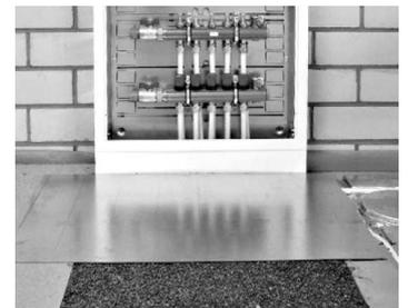
JOCO Trenn- und Gleitlage mit beschichteter Seite nach oben, Ränder 10 cm überlappend verlegen. Sie trennt die Heizebene vom Estrich = klare Trennung der Gewerke.
