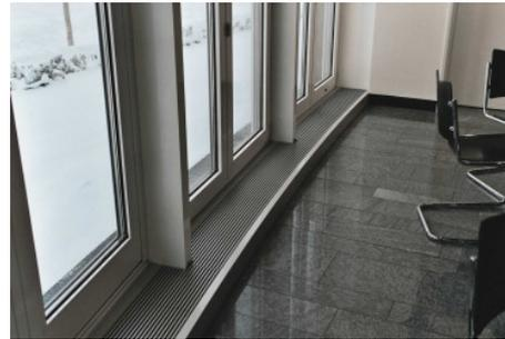
Montierbar wie ein Anbaumöbel mit Steckscharniertechnik – in einheitlichem Design für unterschiedliche Wärmebedarfe im Gebäude durchgängig einsetzbar.
