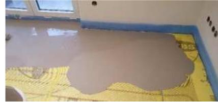
Es ist nur so viel Material anzumischen, wie in der Verarbeitungszeit konsistenzgerecht eingebracht werden kann. Dabei ist darauf zu achten, dass das Material mit dem Glätter oder Gummischieber intensiv „in den Boden“ eingewalkt und verteilt wird. Anschließend mit einer geeigneten Raket, harten Besen, Stachelwalze o. Ä. für eine optimale Nivellierung und Entlüftung des Materials sorgen.
